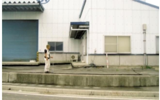
写真 4B 液状化による砂地盤の沈下（鳥取県水産試験センターの南部の倉庫地点）。倉庫の建物は手前側の地面に対して数十 cm 浮かんでいるように見える。この地点では、地盤の最大沈下量は 40 cm に達している。
