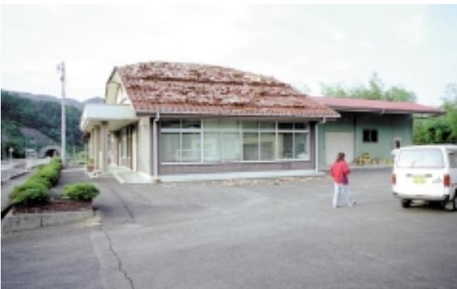
写真 4C 新しい建物の屋根瓦の一部が落下しているが、建物自体に大きな被害は生じていない（西伯町下中谷の公民館）。
