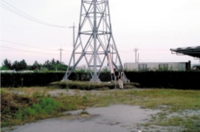
写真 4A 液状化による砂地盤の沈下（鳥取県水産試験センターの敷地内）。鉄塔の基礎は地下数 m に作られているため、その周辺域の砂地盤の液状化に伴う地面の沈下によって鉄塔が浮かんでいるように見える。この地点は観察された地盤沈下量の最も大きいところで、その量は 50 cm に達している。手前側の灰色の部分は噴砂。
