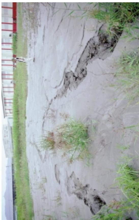
写真 3A 割れ目沿いの液状化による噴砂（竹内団地夢みなど公園の南入口地点）。
